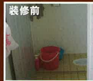
装修前 铺上马赛克地砖的蹲式厕所
